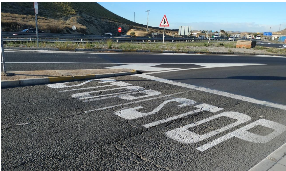
Fotografía 13. Pintura señalización transversal, calle Arco Iris. Fuente: Elaboración propia.
