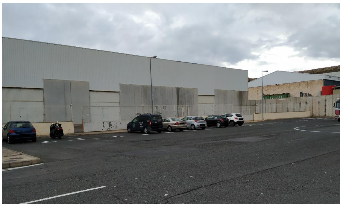
Fotografía 17. Estacionamiento público del área industrial Pla de la Vallonga. Fuente: Elaboración propia.
